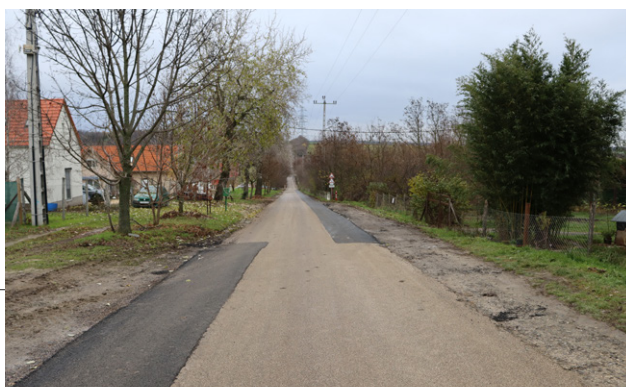
Külterületi utak felújítása
