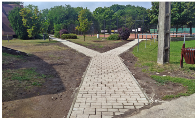
Járdaépítés a sportközpontban
