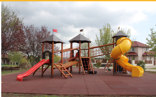
Csillagfürt játszótér átépítésének befejezése
