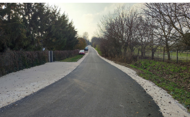
Rákóczi-Petőfi összekötő út megépítése
