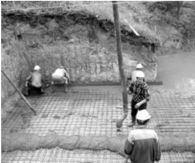
Készül a pincszinti szerelőbeton (július 30.)
