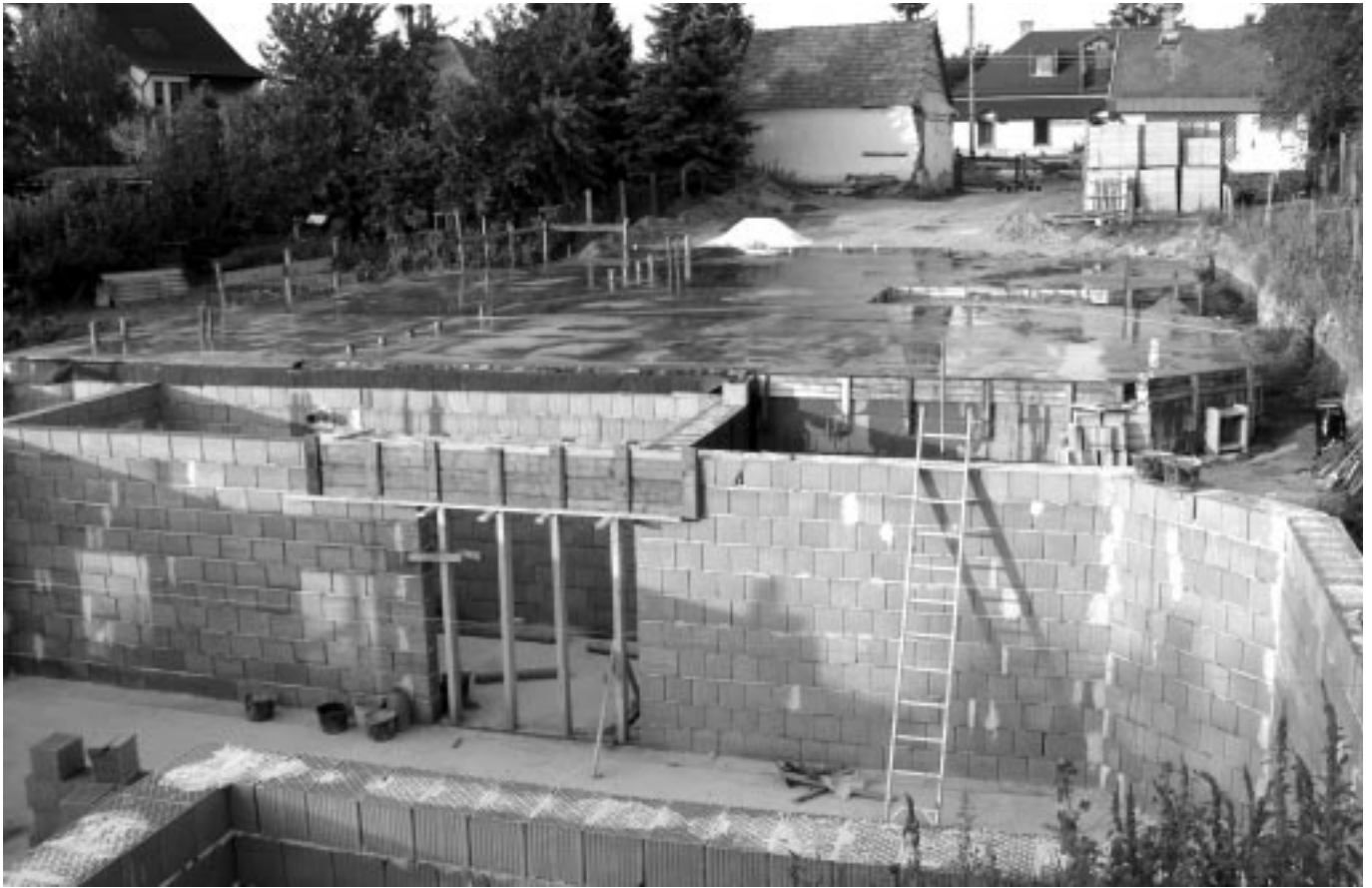
Elkészült a pince falazata és a csoportszobák szerelőbetonja (alatta a szennyvízvezeték) (szeptember 3.)
