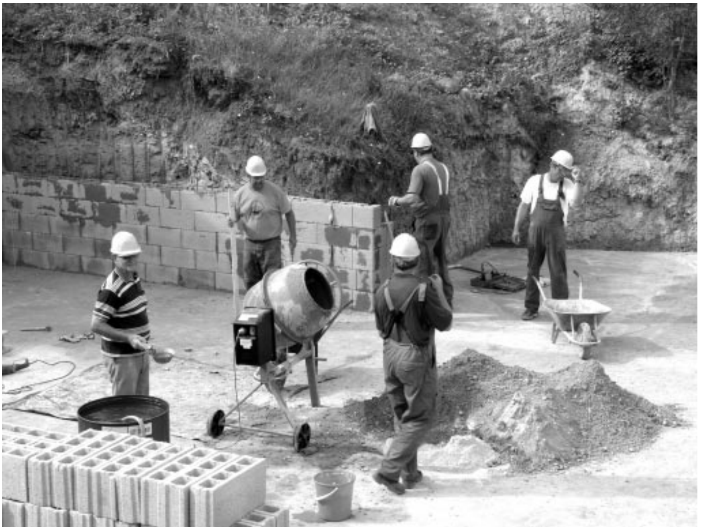
Épül a szigeteléstartó fal (augusztus 8.)
