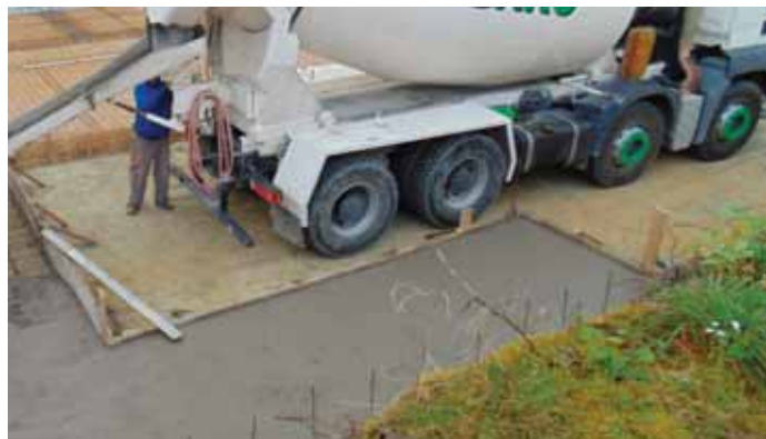
elkezdődött az iskola bővítése
