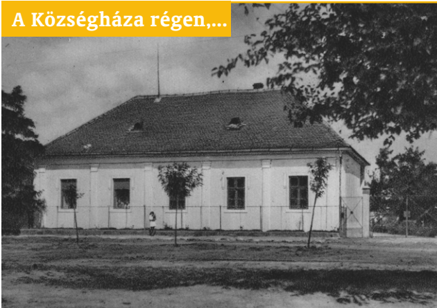
...a felújítás előtt...
